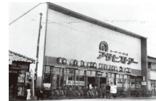
▲大阪で開業した「アサヒストア」（1962年）
